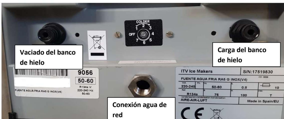
Antes de realizar la conexión eléctrica y la conexión de red, debemos realizar la carga del banco de hielo.
