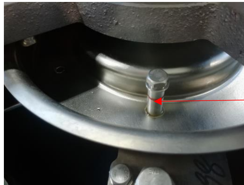
Bandeja parte superior generador, tornillo marca regulación agua
