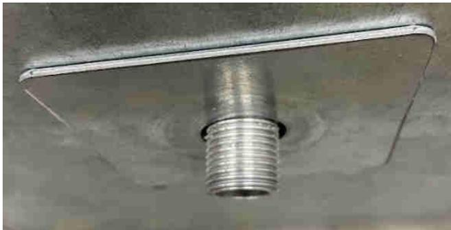
**PASSO 7:** Avvitare il MANICOTTO MISTO RIDOTTO al coperchio dello scarico che sporge da sotto il serbatoio. Il rinforzo rimane appena sopra.
