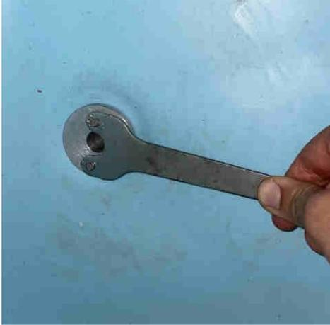
**ÉTAPE 6 :** En bas, à l'extérieur du silo, nous placerons la plaque de renforcement. Insérez le fil saillant du couvercle dans le trou de la plaque de renforcement.
