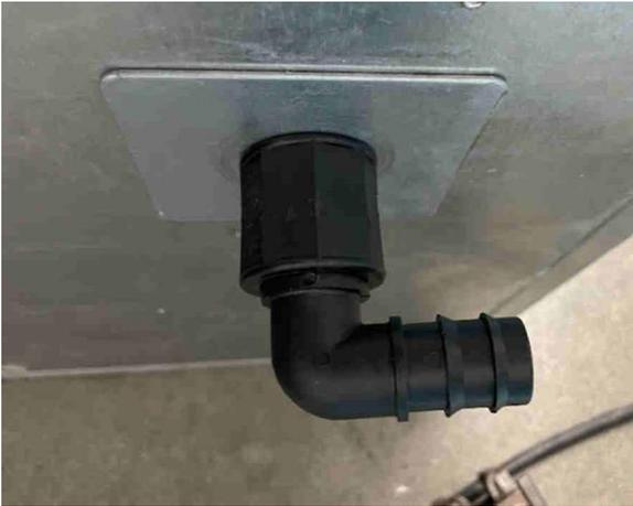
**ÉTAPE 8 :** Enfin, le bouchon étant maintenu en place avec la clé à ergot et le tuyau réduit étant maintenu en place avec la pince à bec de perroquet, nous pouvons maintenant serrer le kit pour qu'il n'y ait pas de fuite d'eau. Il sera vissé jusqu'au bout.
