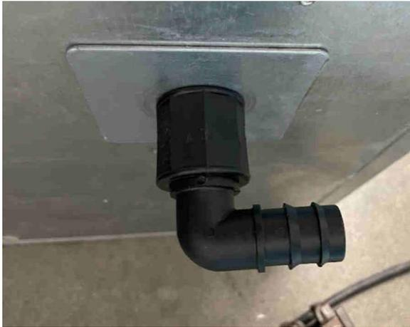
**PASO 8:** Finalmente, con el tapón sujeto con la llave para amoladora y el manguito reducido sujeto con el pico de loro, ya podemos apretar el kit para que no fugue agua. Se roscará hasta que la pieza negra haga tope.
