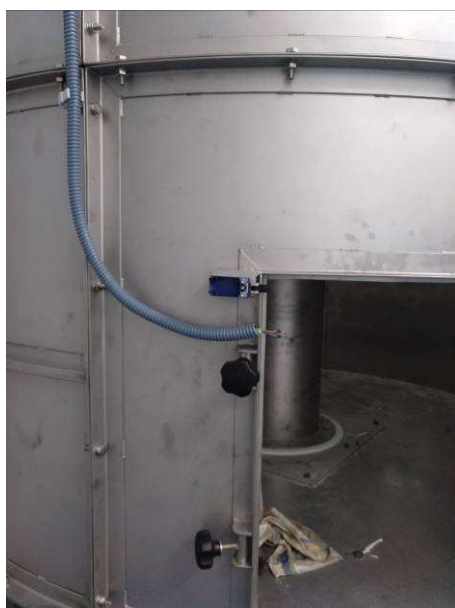
Relé seguridad apertura puerta
