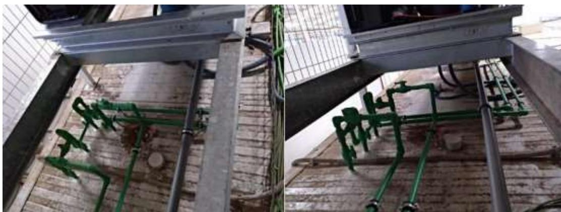
*Montaggio tubi con bypass al coperto padiglione*
