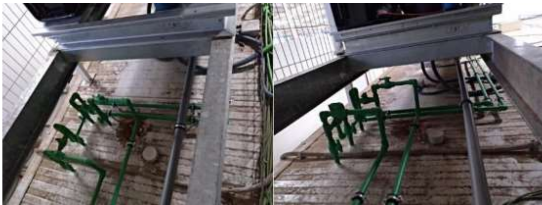
Installation de tuyauterie avec dérivation sur la partie supérieure de l'appareil
