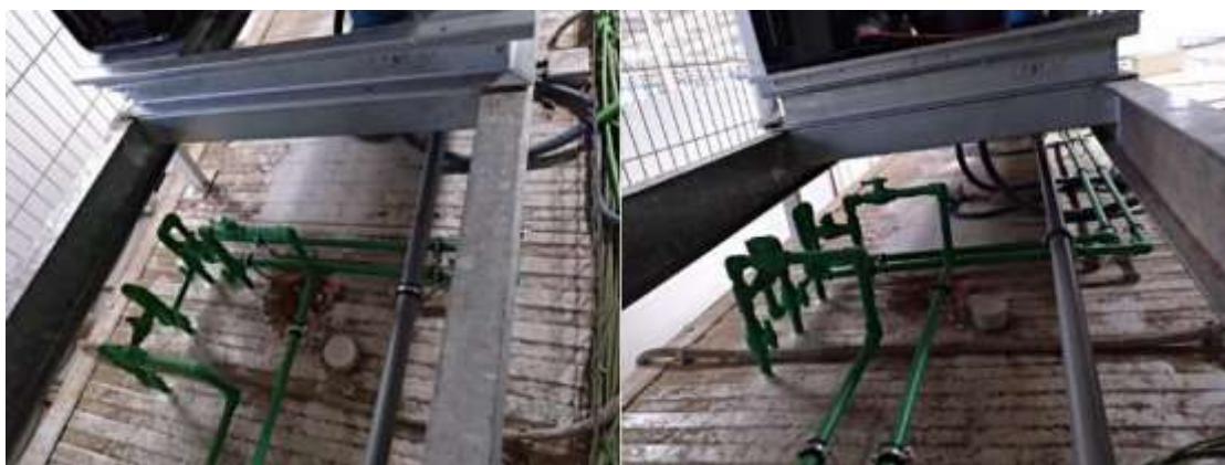
Montaje tuberías con bypass en cubierta nave
