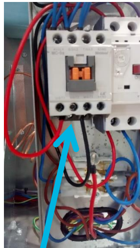
Máquinas modulares: cable rojo salida contactor a compresor (intermedio)
