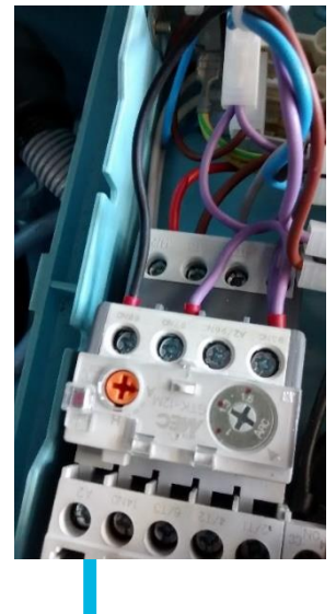
Nicht-modulare Einheit: rotes Kabel abziehen oder, wenn vorhanden, Reinigungsschalter verwenden
